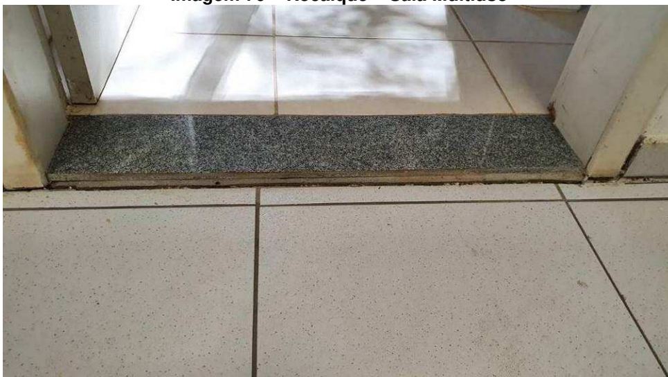
Imagem 70 – Recalque – Sala Multiuso
