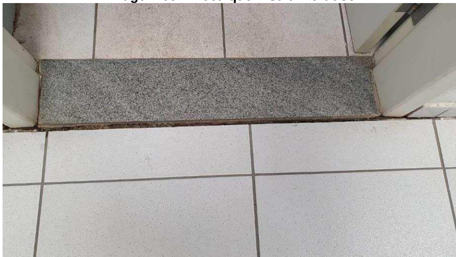
Imagem 69 – Recalque – Sala Multiuso
