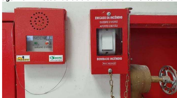
Imagem 64 – Botoeiras de alarme e acionamento da bomba
