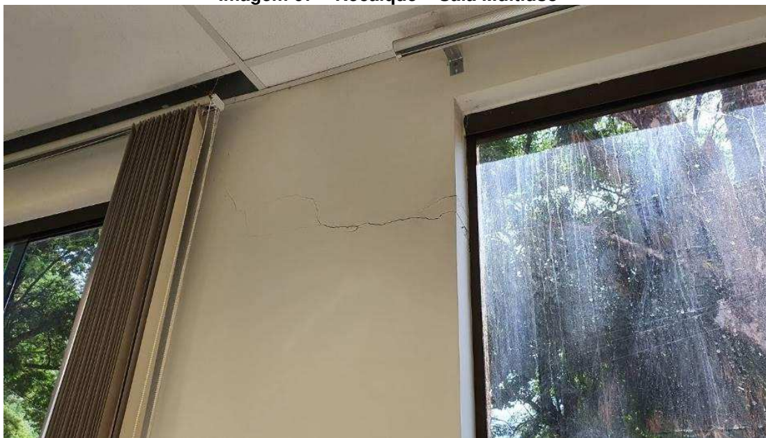
Imagem 67 – Recalque – Sala Multiuso
