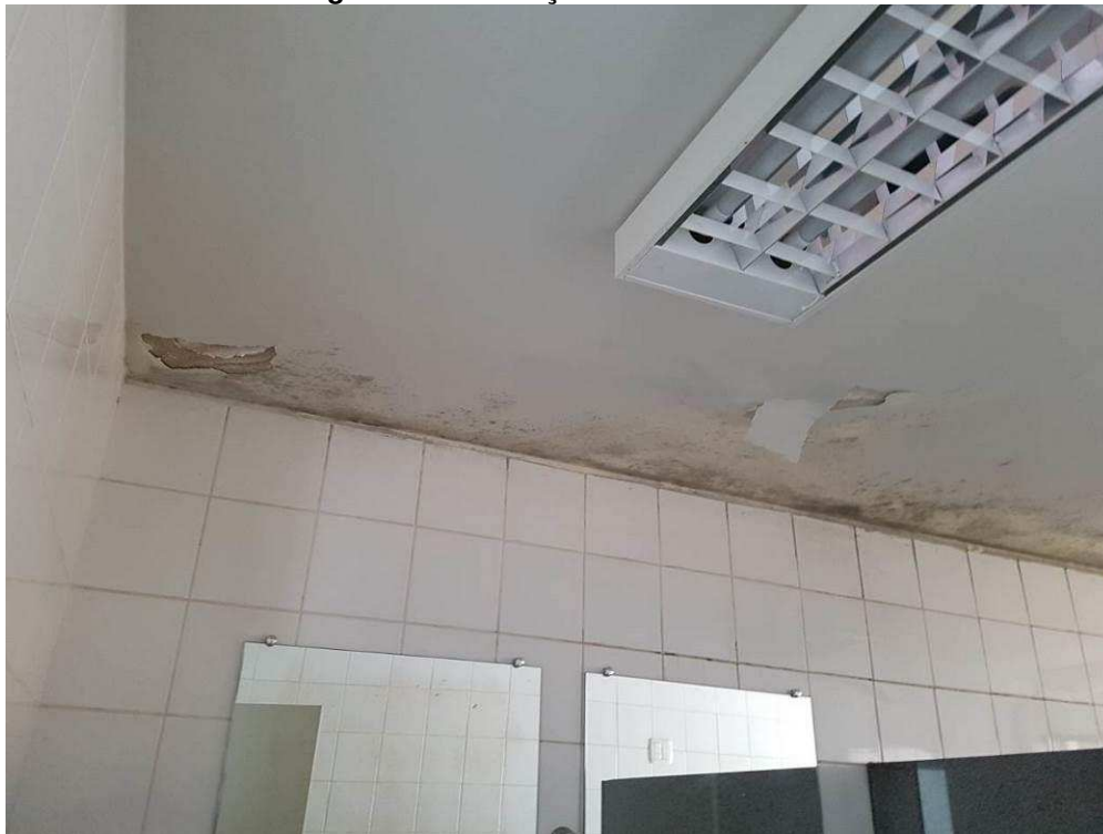
Imagem 30 - Infiltração Banheiros C.A.E.
