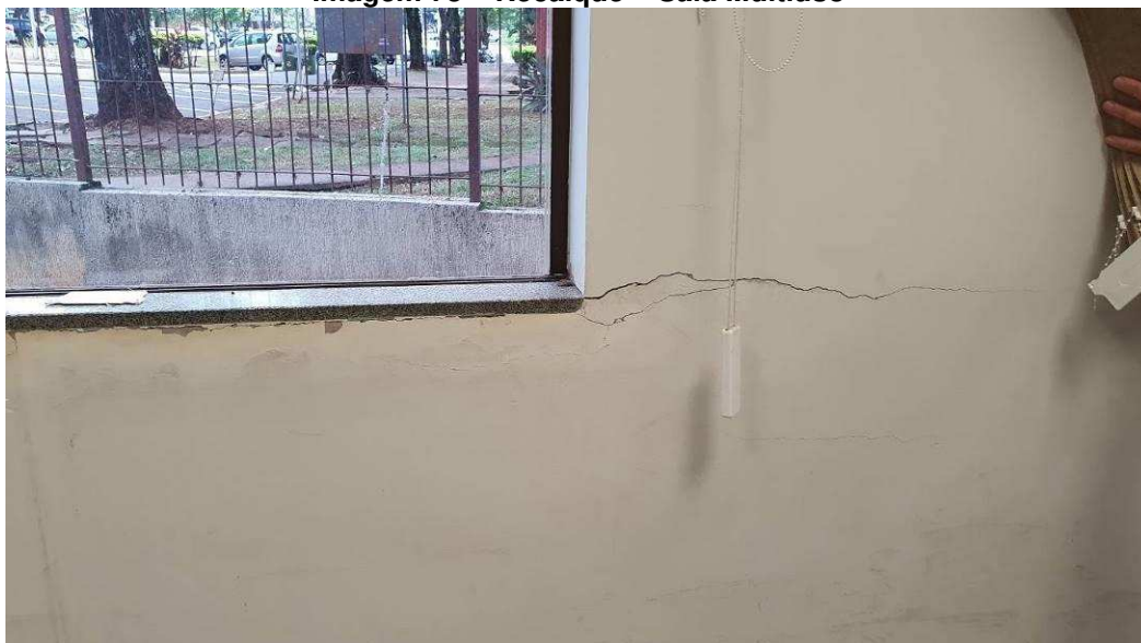
Imagem 73 – Recalque – Sala Multiuso
