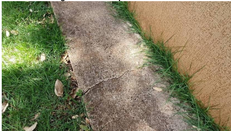
Imagem 77 – Recalque – Sala Multiuso
