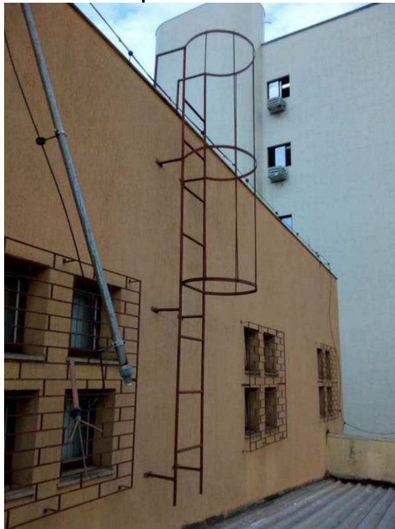
Imagem 56 – Escada Marinheiro para acesso a cobertura do Depósito de Urnas
