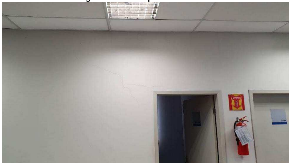
Imagem 74 – Recalque – Sala Multiuso
