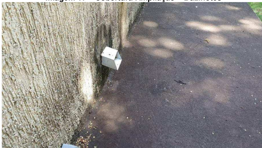
Imagem 17 – Cobertura Ampliação – Buzínótes
