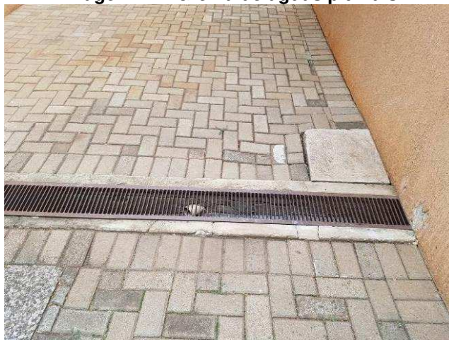
Imagem 47 - Grelha de águas pluviais
