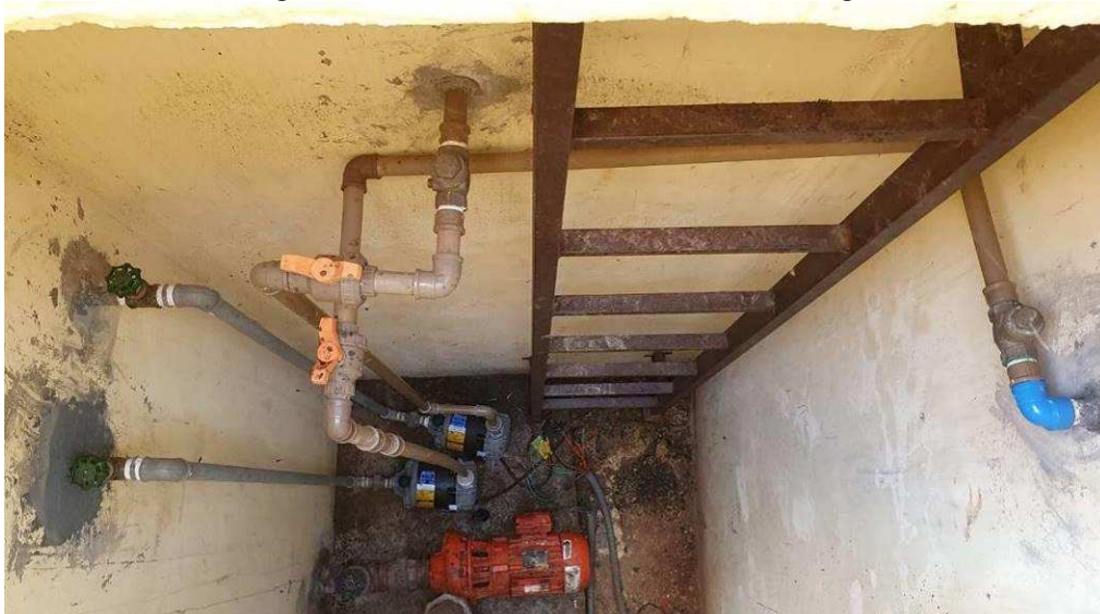
Imagem 49 – Bombas de abastecimento de água
