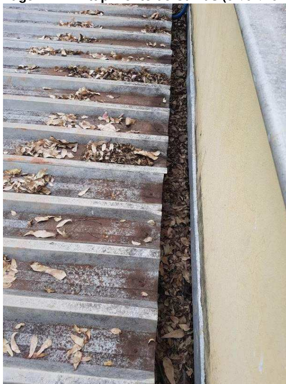
Imagem 1 – Entupimento de Calhas (04/04/2019)
